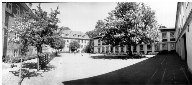
Med den nye bygning fra 1968 fik skolen for første gang egentlige faglokaler og en stor gymnastiksal, der også kan anvendes som teatersal. I 2001-2002 fik bygningen endnu en etage.
